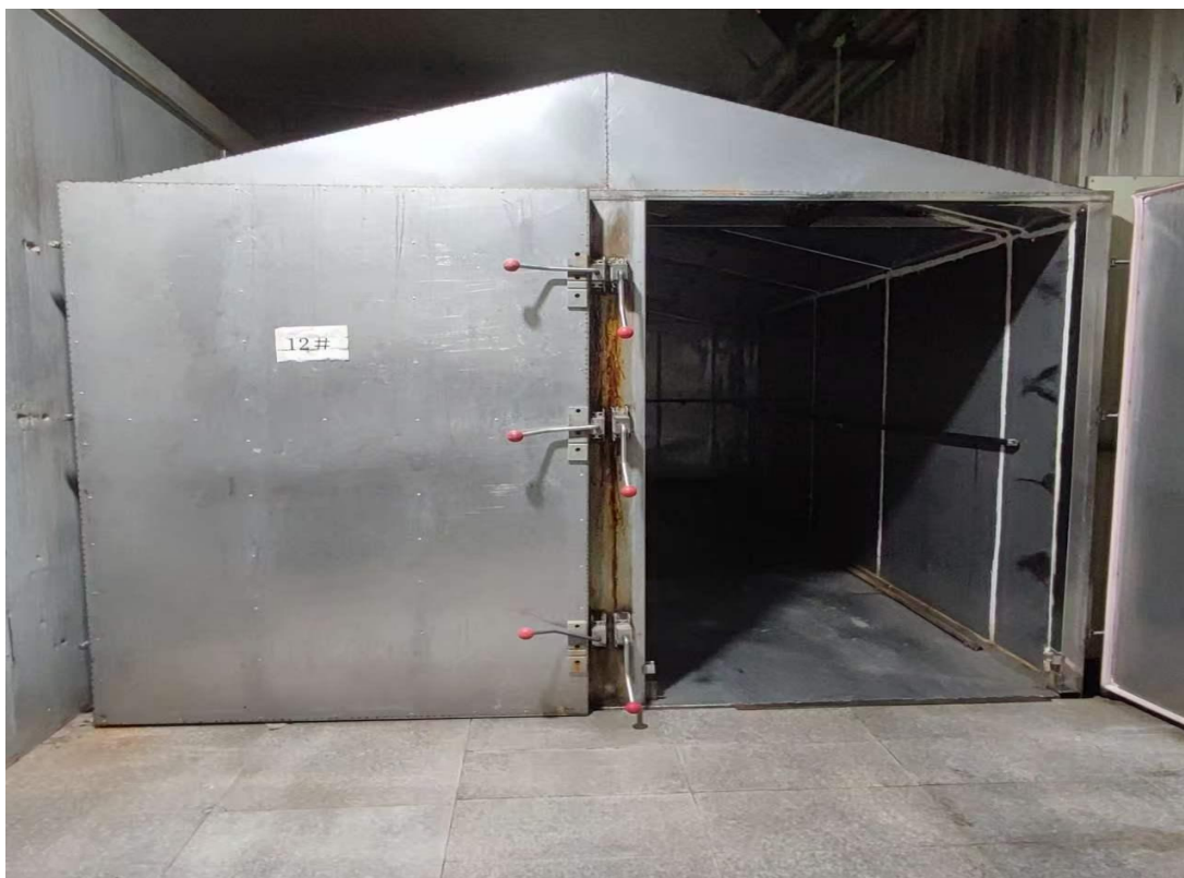
图 3 蒸房左扇门日常锁闭状态正面照片
